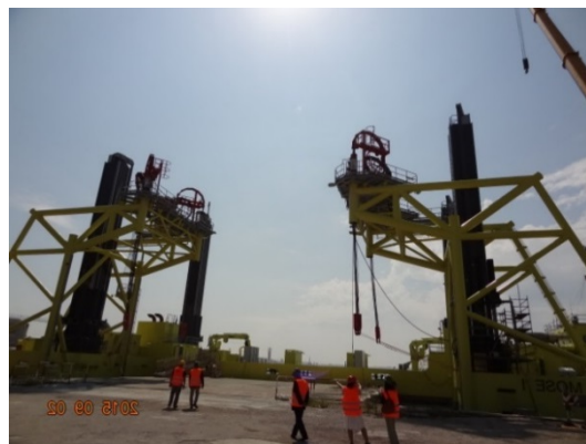
15年間で一通りゲートの点検補修がなされる計画
